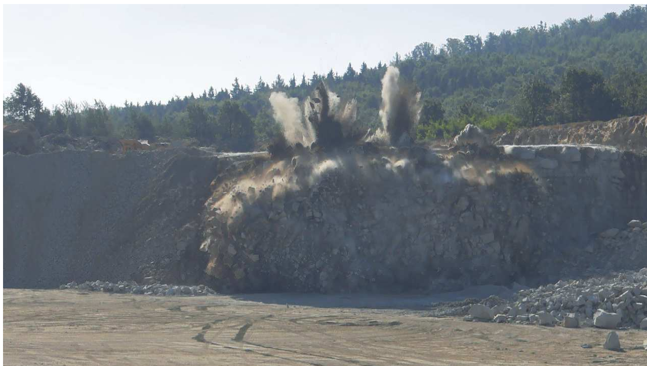
Fot. 7 Moment odpalenia ładunków materiału wybuchowego w otworach.
