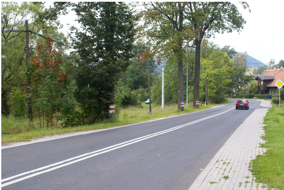
Rycina 12 Istniejące nasadzenia drzew wzdłuż DK 35 (widok z obiektu w stronę Mieroszowa).
