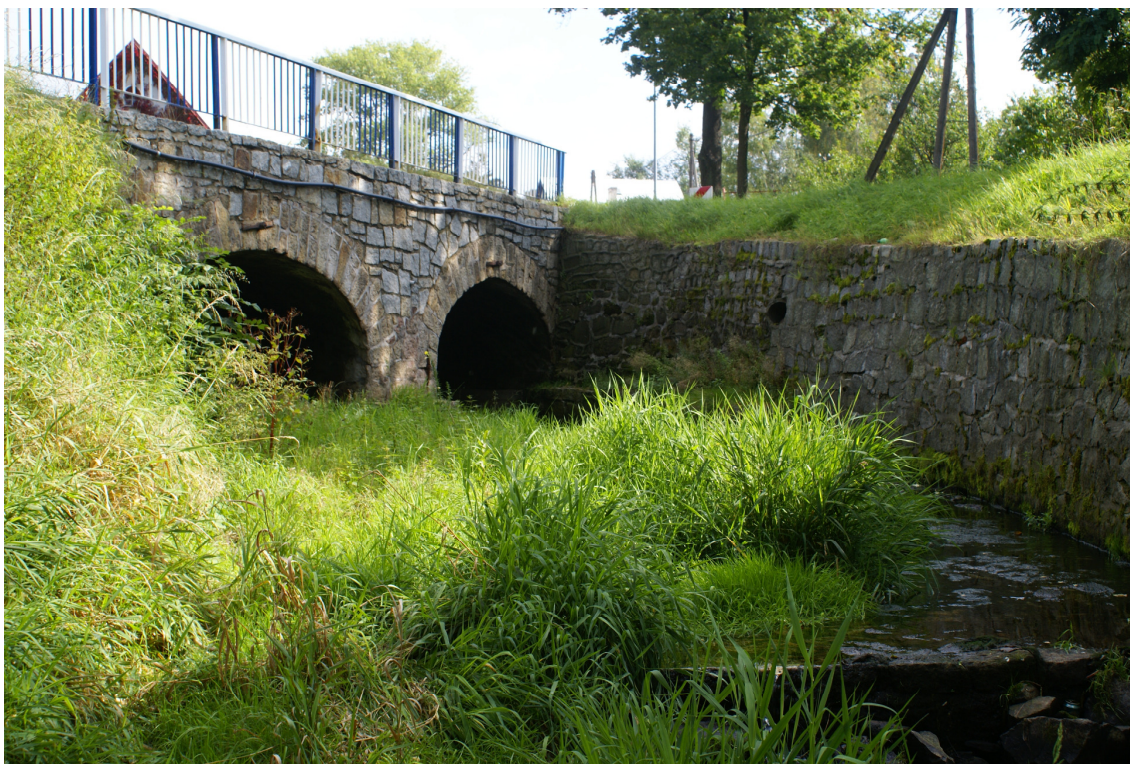
Rycina 11 Szata roślinna w bezpośrednim otoczeniu przebudowanego mostu (strona prawa DK35).
