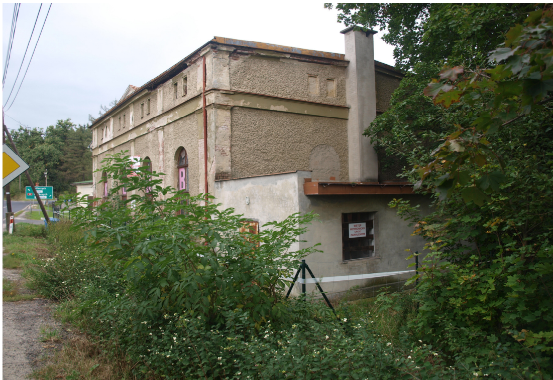
Rycina 16 Budynek przewidziany do wyburzenia podczas wykonywania drogi objazdowej.
