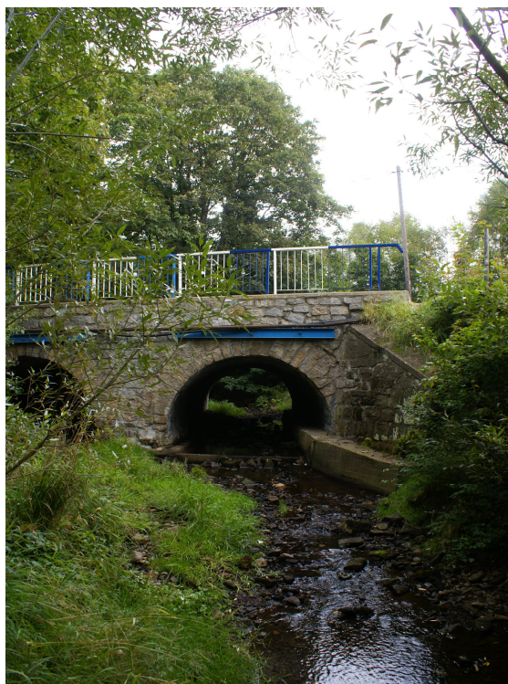
Rycina 12 Szata roślinna w bezpośrednim otoczeniu przebudowanego mostu (strona prawa DK35).
